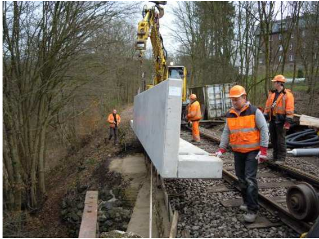
Abb 2: Einbau des Betonfertigteils am Widerlager Dahlerau durch die Firma Klostermann
