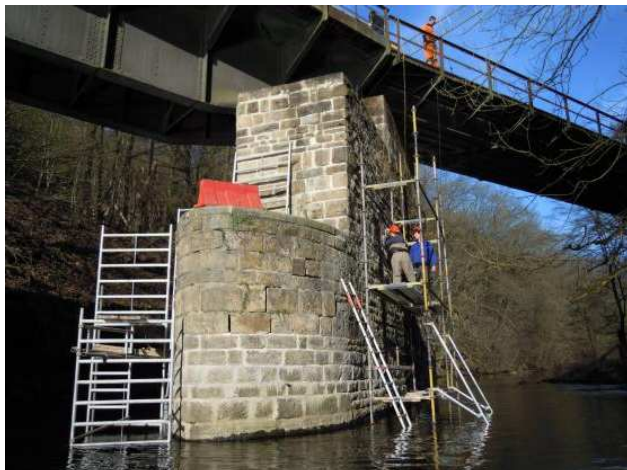
Abb 1: Sanierungsarbeiten der Vereinsmitglieder am Brückenpfeiler in der Wupper.
